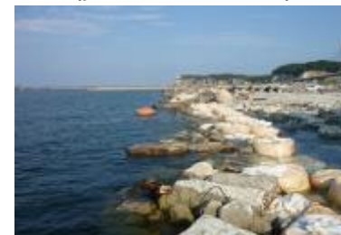
岸壁の復旧事例（松川浦漁港）
