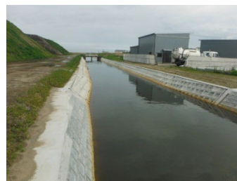
津波で損壊した排水路の復旧状況
