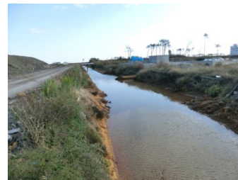
【仙台東】大堀排水路
