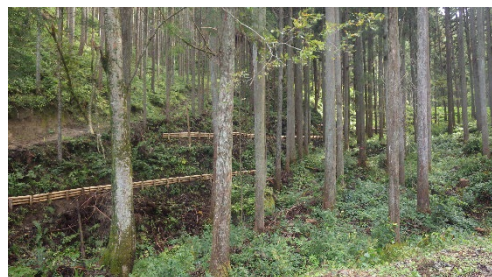
筋工による放射性物質の移動抑制対策
