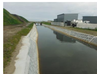
津波で損壊した排水路の復旧状況
