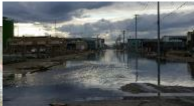
水産加工団地の冠水状況
