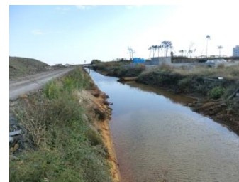
【仙台東】大堀排水路
