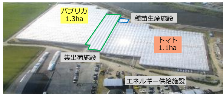
次世代施設園芸 宮城県拠点
