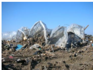
被災した園芸施設
