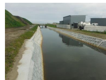
津波で損壊した排水路の復旧状況
