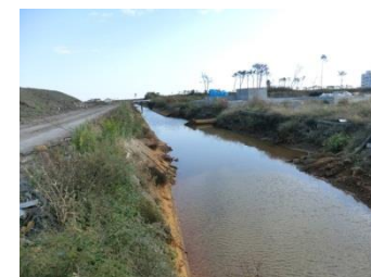
【仙台東】大堀排水路
