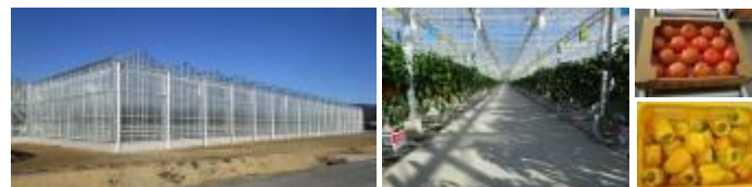
高軒高のガラス温室
