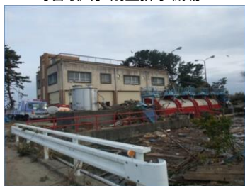
【名取川】閘上排水機場
