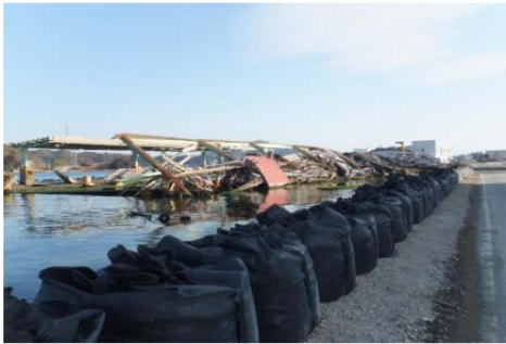
荷さばき所の被害状況
