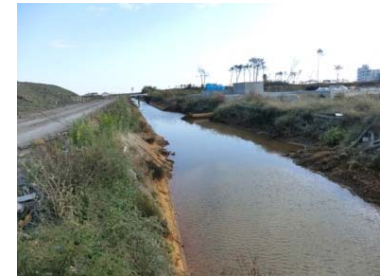
【仙台東】大堀排水路
