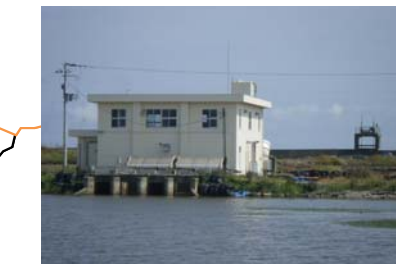
損壊した建屋及びポンプ設備の復旧状況
