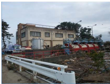
【名取川】閘上排水機場
