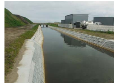
津波で損壊した排水路の復旧状況
