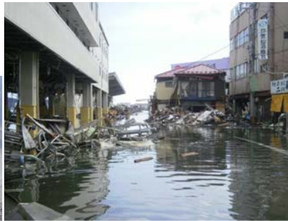
浸水した荷さばき所背後
