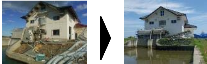
排水機場の復旧状況(谷地排水機場)
