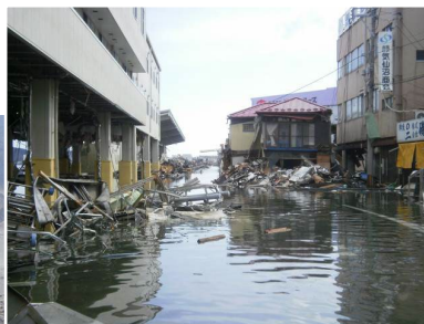
浸水した荷さばき所背後
