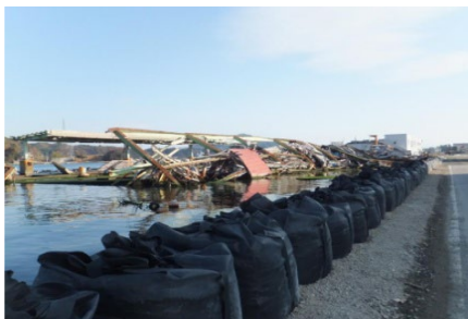
荷さばき所の被害状況
