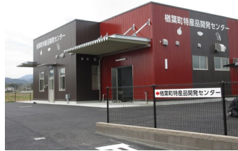
令和4年度に整備した檜葉町特産品開発センター
