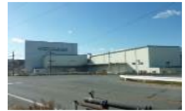
福島再生加速化交付金を活用したカントリーエレベーター
