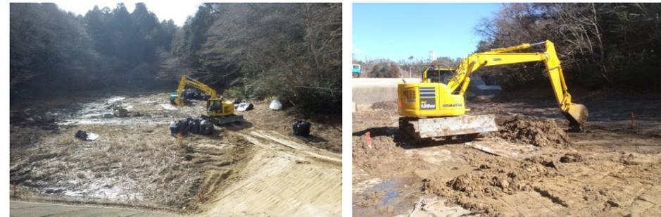
落水後、バックホウ等により底質を掘削し分級、脱水等を行った後に、中間貯蔵施設へ搬入するため、大型土のう袋等へ詰込みを行う。
