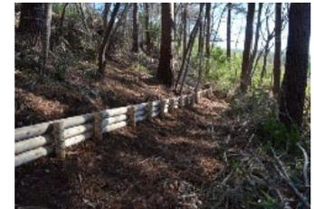
土砂移動抑制のため、筋工を施工
