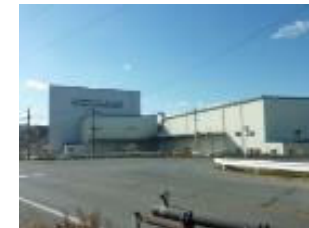
福島再生加速化交付金を活用した カントリーエレベーター
