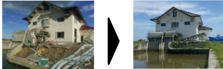
排水機場の復旧状況(谷地排水機場)
