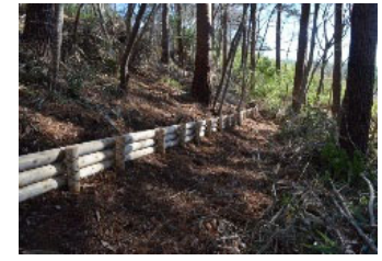
土砂移動抑制のため、筋工を施工
