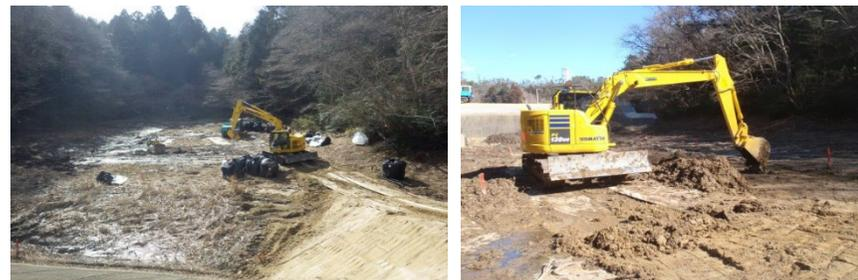
落水後、バックホウ等により底質を掘削し分級、脱水等を行った後に、中間貯蔵施設へ搬入するため、大型土のう袋等へ詰込み。
