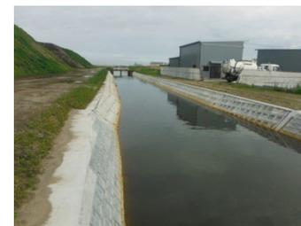
津波で損壊した排水路の復旧状況
