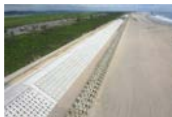
海岸堤防の復旧状況
