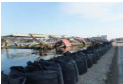
荷さばき所の被害状況
