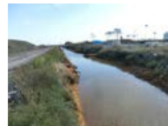
【仙台東】大堀排水路
