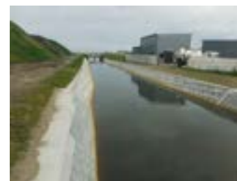
津波で損壊した排水路の復旧状況
