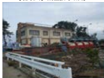
【名取川】関上排水機場
