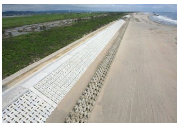
海岸堤防の復旧状況
