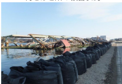
荷さばき所の被害状況
