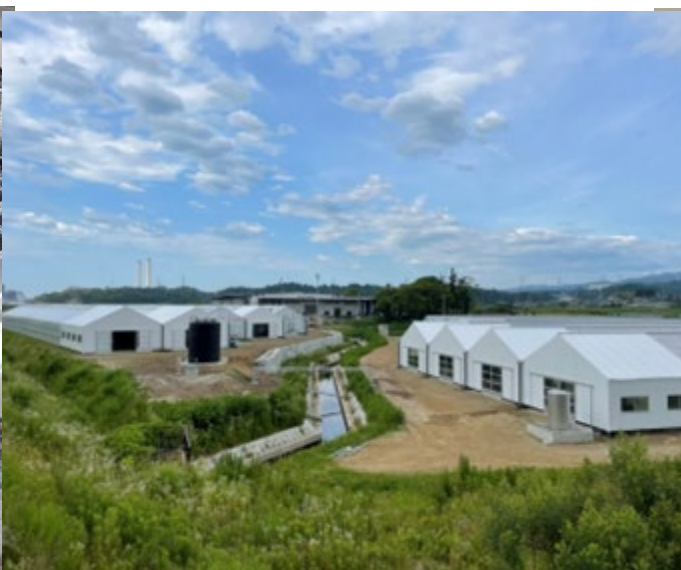
かんしょ高品質苗供給施設（楢葉町）
