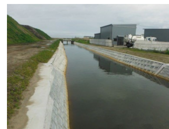
津波で損壊した排水路の復旧状況
