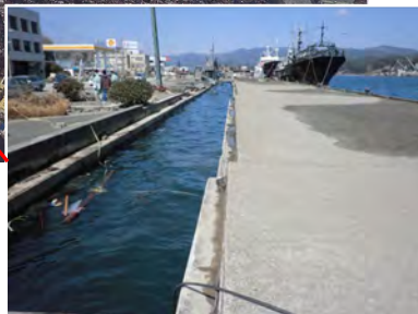
倒壊した岸壁
