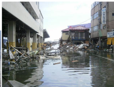
浸水した荷さばき所背後
