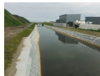
津波で損壊した排水路の復旧状況
