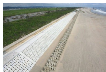
海岸堤防の復旧状況
