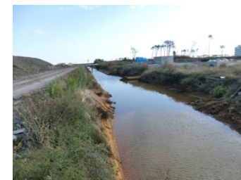
【仙台東】大堀排水路
