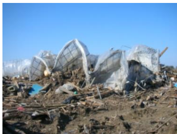
被災した園芸施設
