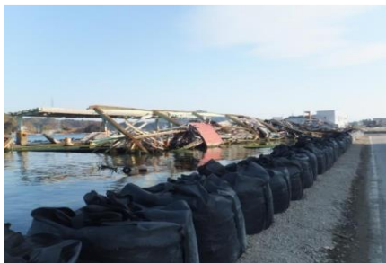
荷さばき所の被害状況
