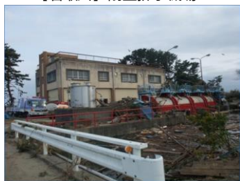
【名取川】閘上排水機場
