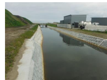
津波で損壊した排水路の復旧状況
