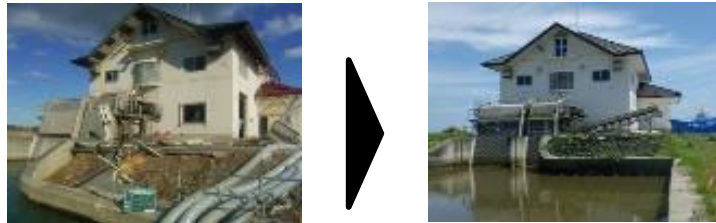
排水機場の復旧状況(谷地排水機場)
