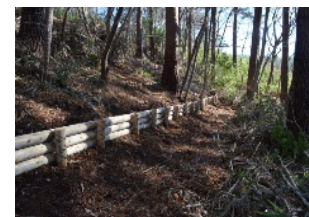
土砂移動抑制のため、筋工を施工
