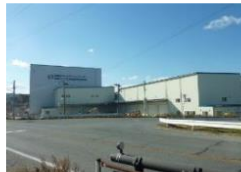
福島再生加速化交付金を活用したカントリーエレベーター
