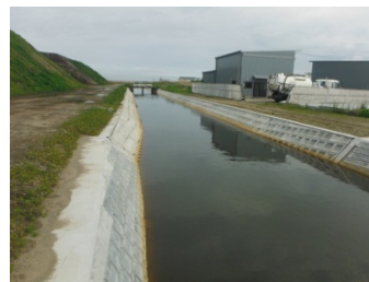
津波で損壊した排水路の復旧状況
