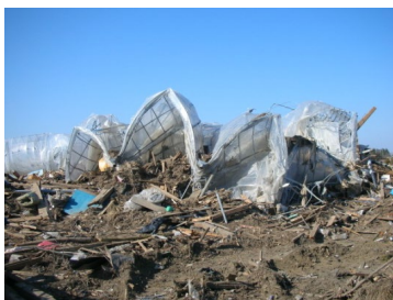
被災した園芸施設
