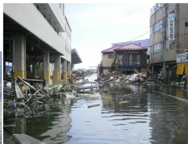
浸水した荷さばき所背後
