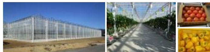
高軒高のガラス温室
