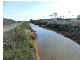
【仙台東】大堀排水路
