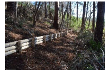
土砂移動抑制のため、筋工を施工
