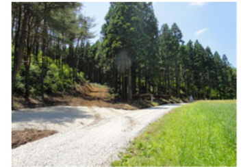
間伐と森林管理に必要な作業道を整備
