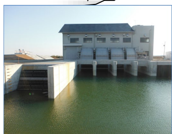
損壊した建屋及びポンプ設備の復旧状況
