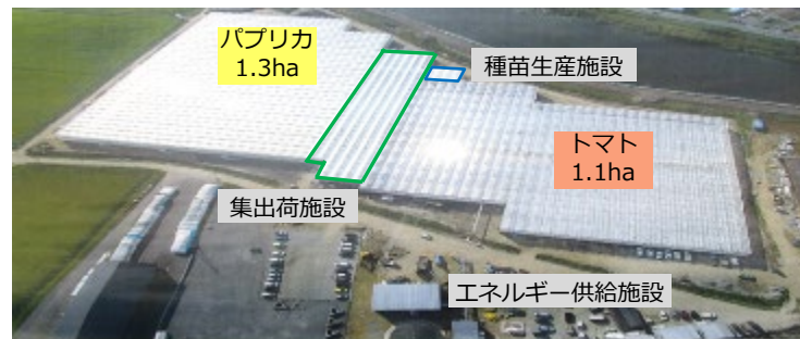
次世代施設園芸 宮城県拠点
