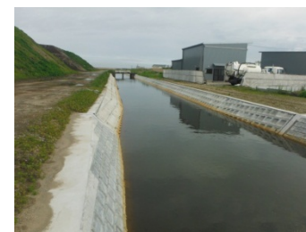
津波で損壊した排水路の復旧状況
