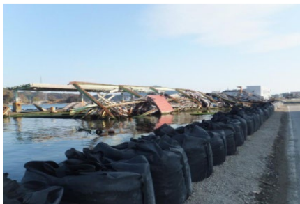
荷さばき所の被害状況
