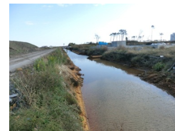
【仙台東】大堀排水路
