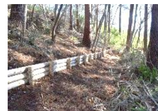
土砂移動抑制のため、筋工を施工
