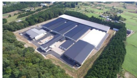
フェリスラテ施設全景
