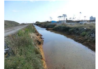
【仙台東】大堀排水路
