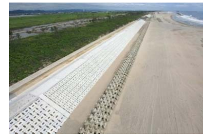
海岸堤防の復旧状況
