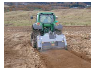
ストーンクラッシャーによる石礫破碎
