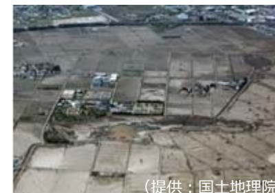
農地の復旧事例（仙台市）
