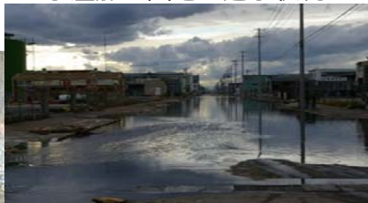
水産加工団地の冠水状況
