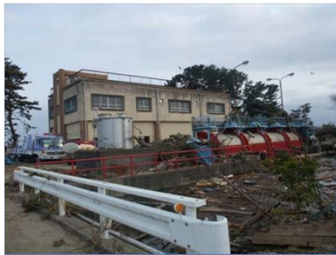
【名取川】閘上排水機場
