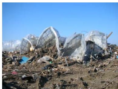
被災した園芸施設
