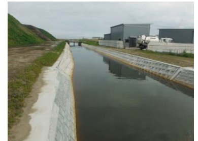
津波で損壊した排水路の復旧状況
