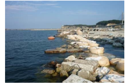
岸壁の復旧事例 (松川浦漁港)
