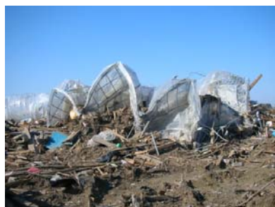
被災した園芸施設
