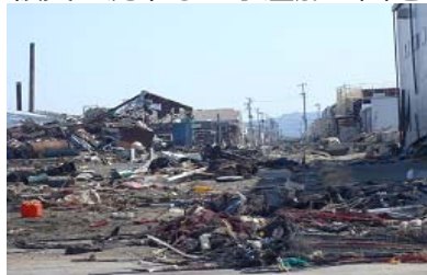
被災・沈下した水産加工団地
