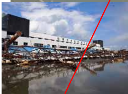
市場の倒壊、冠水
