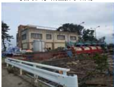
【名取川】閘上排水機場
