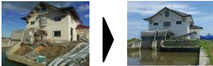
排水機場の復旧状況(谷地排水機場)
