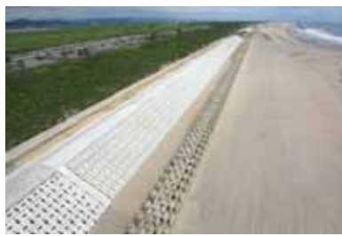
海岸堤防の復旧状況
