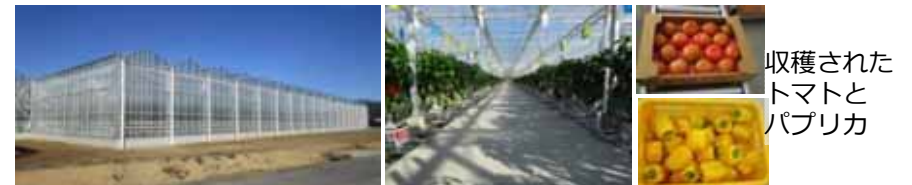
高軒高のガラス温室
