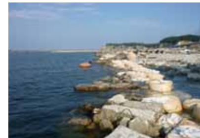
岸壁の復旧事例 (松川浦漁港)
