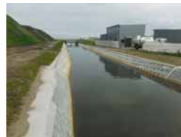
津波で損壊した排水路の復旧状況
