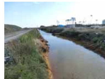
【仙台東】大堀排水路
