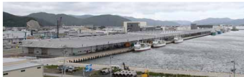
高上げた岸壁と完成した水産物卸売市場
