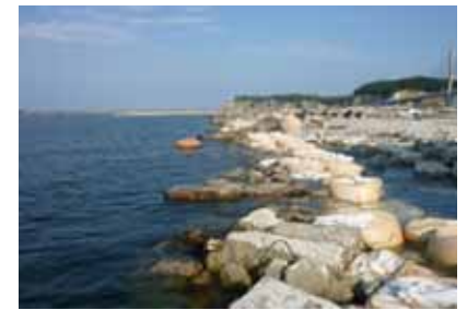
岸壁の復旧事例 (松川浦漁港)
