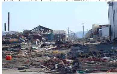
被災・沈下した水産加工団地
