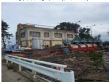
【名取川】閑上排水機場
