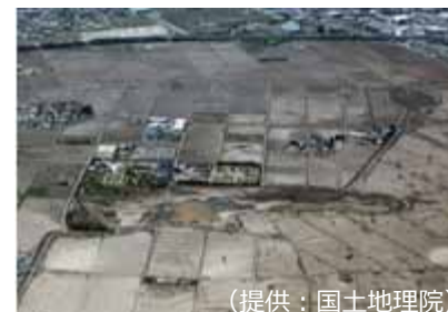
農地の復旧事例（仙台市）
