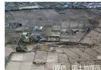
農地の復旧事例（仙台市）
