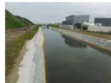
津波で損壊した排水路の復旧状況
