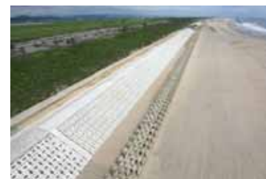
海岸堤防の復旧状況
