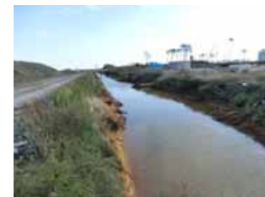
【仙台東】大堀排水路
