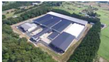
フェリスラテ施設全景
