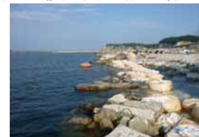
岸壁の復旧事例 (松川浦漁港)
