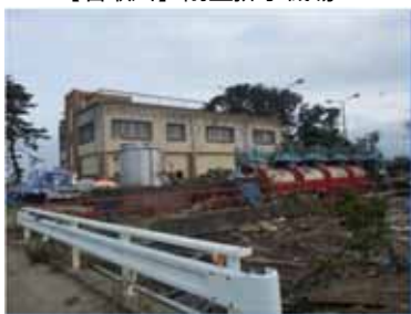
【名取川】閑上排水機場
