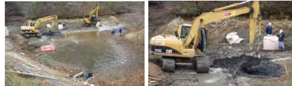
放射性セシウム濃度の高い底質を固化材を使用して固化する工法や、高濃度の底質（表層）と低濃度の底質（下層）をそれぞれ土壌改良して上下で入れ替える（反転）工法がある。底質からの巻き上がりや、底質からの溶出を抑制する。
