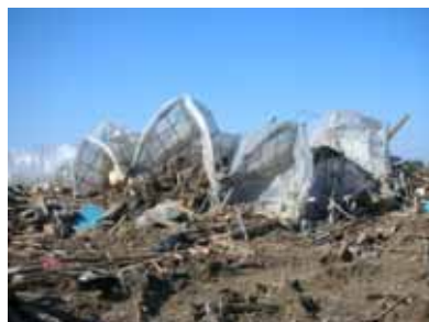
被災した園芸施設
