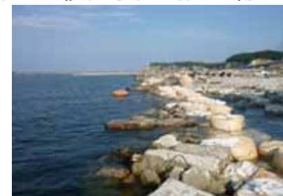
岸壁の復旧事例 (松川浦漁港)
