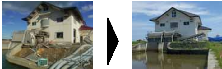
排水機場の復旧状況(谷地排水機場)
