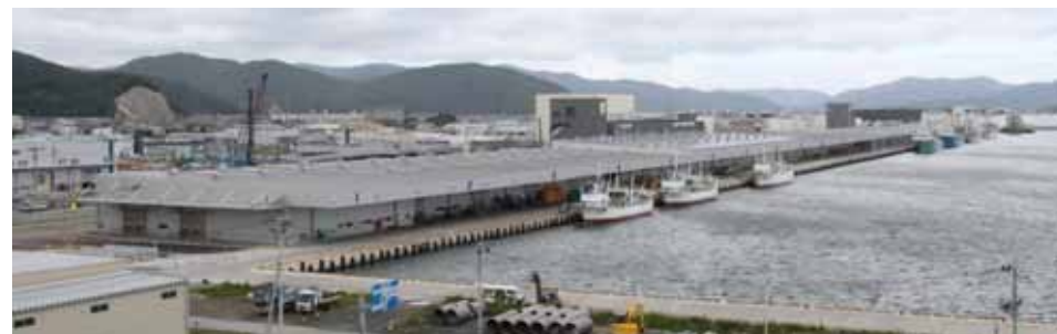
嵩上げた岸壁と完成した水産物卸売市場
