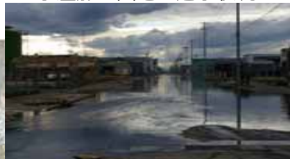
水産加工団地の冠水状況
