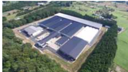
フェリスラテ施設全景
