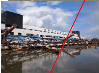
市場の倒壊、冠水
