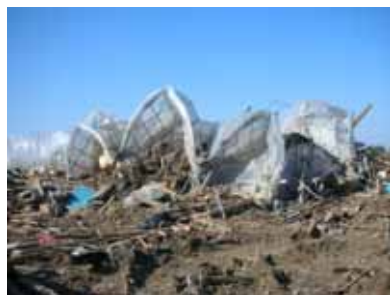
被災した園芸施設
