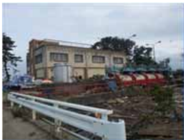
【名取川】閑上排水機場
