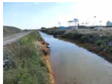
【仙台東】大堀排水路
