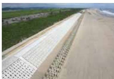
海岸堤防の復旧状況
