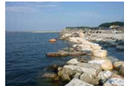
岸壁の復旧事例 (松川浦漁港)
