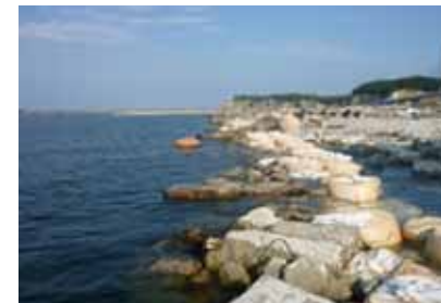
岸壁の復旧事例 (松川浦漁港)
