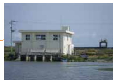
損壊した建屋及びポンプ設備の復旧状況
