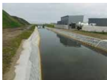
津波で損壊した排水路の復旧状況
