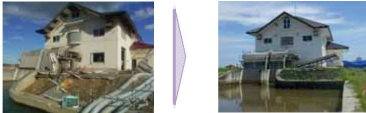
排水機場の復旧状況(谷地排水機場)
