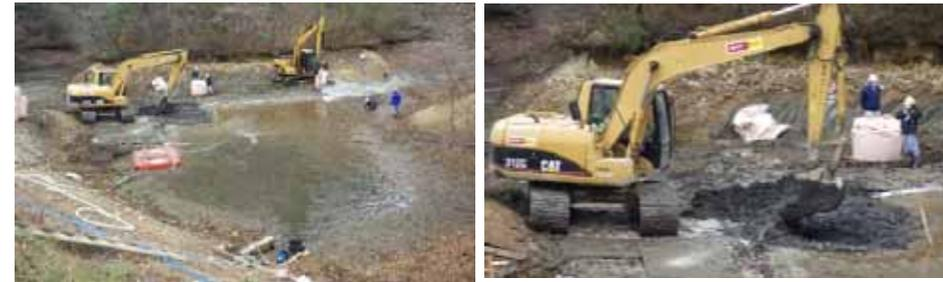
・放射性セシウム濃度の高い底質を、固化材を使用し固化する工法や、高濃度の底質（表層）と低濃度の底質（下層）をそれぞれ土壤改良し上下で入れ替える（反転）工法があり、底質からの巻き上がりや、底質からの溶出を抑制する
