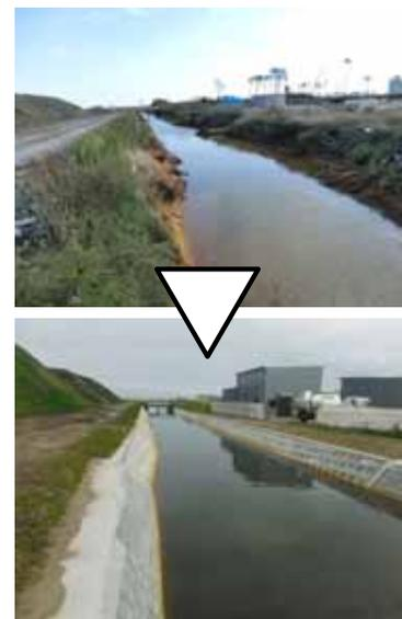
※津波で護岸が損壊した排水路の復旧が完了（上：被災後、下：復旧後）
