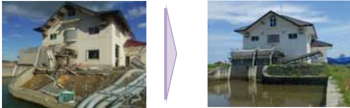
排水機場の復旧状況(谷地排水機場)
