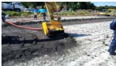
固化剤を用いた削り取り
