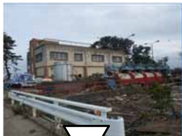
【名取川】関上排水機場
