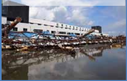
市場の倒壊、冠水
