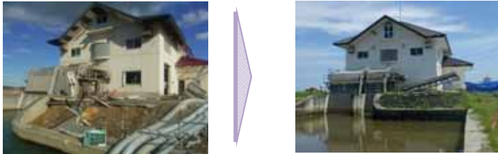
排水機場の復旧状況(谷地排水機場)
