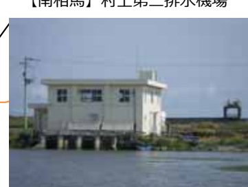
※損壊した建屋及びポンプ設備の復旧が完了
