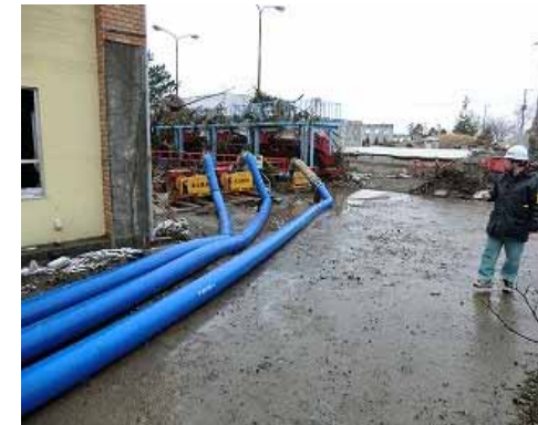
災害応急用ポンプによる排水作業（宮城県名取市）
