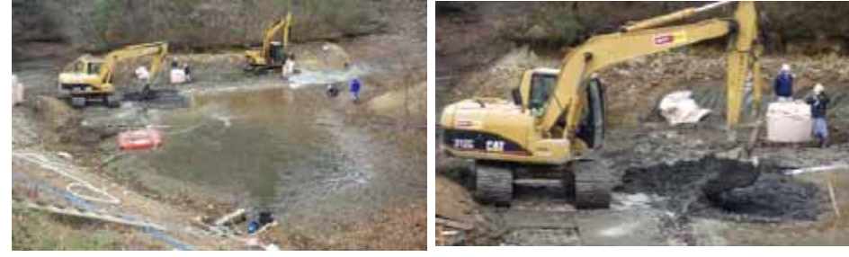
《固化材の攪拌状況》
