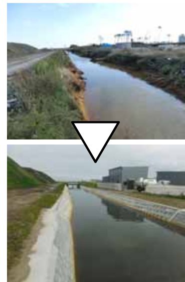
※津波で護岸が損壊した排水路の復旧が完了（上：被災後、下：復旧後）
