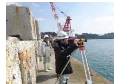
防波堤復旧工事の出来形確認
