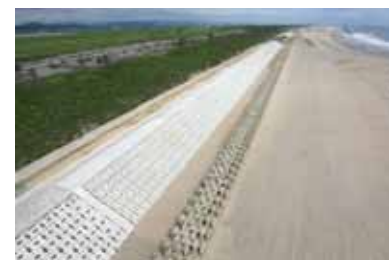
※一部、完成した堤防
