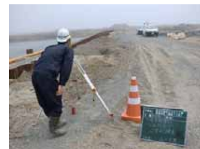
防災林造成工事の出来形確認
