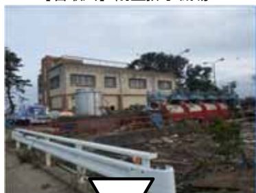
【名取川】関上排水機場
