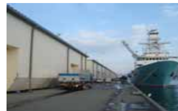
嵩上げた岸壁と完成した水産物卸売市場
