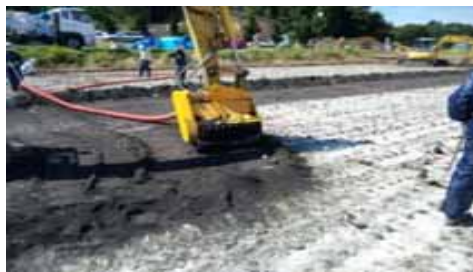
固化剤を用いた削り取り
