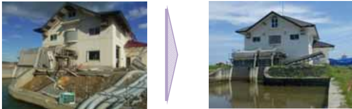
排水機場の復旧状況(谷地排水機場)
