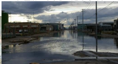
水産加工団地の冠水状況
