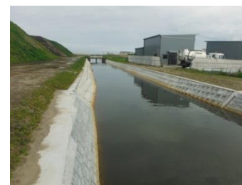
津波で損壊した排水路の復旧状況
