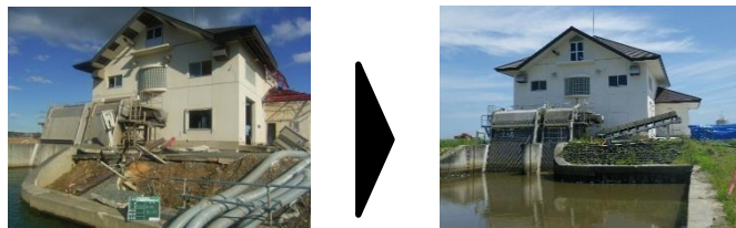
排水機場の復旧状況(谷地排水機場)
