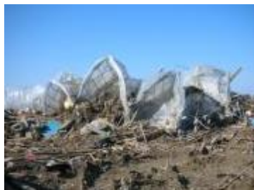
被災した園芸施設
