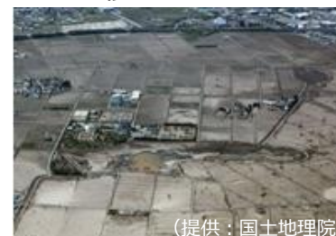
農地の復旧事例（仙台市）
