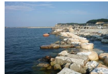
岸壁の復旧事例 (松川浦漁港)
