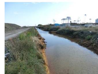
【仙台東】大堀排水路
