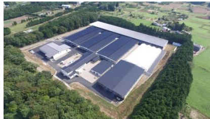
フェリスラテ施設全景
