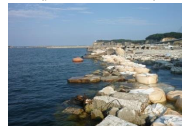
岸壁の復旧事例（松川浦漁港）
