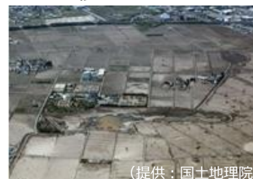
農地の復旧事例（仙台市）
