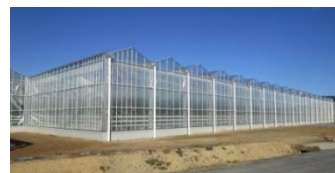
高軒高のガラス温室
