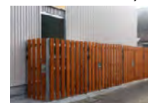
CNF含有塗料により変色が抑制され美観維持に効果的
