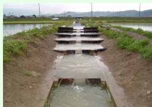
排水路堰上げ式水田魚道
