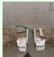
水路と水田との接続部
