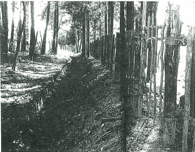
長野県塩尻市片丘南内田（県林業総合センター敷地内）に復元された「鉢伏連峰西麓の猪土手」。松本市中山から塩尻市下西条までの南北28°にわたって築かれていた遺構の一部。山側に深さ約1.5mの堀、土を里側に盛った土手、土手の上に高さ1.2mの柵がある。山側への入り口には木戸も設けられている＝塩尻市教委提供
