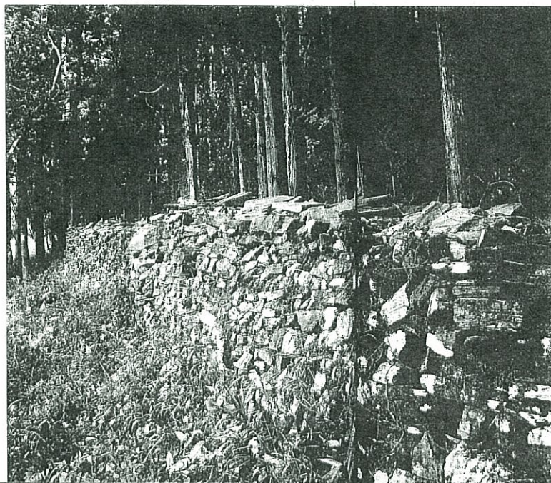
愛知県岡崎市中金町の「万足平の猪垣」（岡県民俗有形文化財）。男川産の片麻岩を山すそを囲むように延べ60°にわたって築かれている。高さ2m、上面幅0.6m、下面幅約1mで、外側が土手になっている所もある。古文書では延享3年（1746）から幕末にかけて、また文化2年（1805）の二期に築かれたとされる＝岡崎市提供
