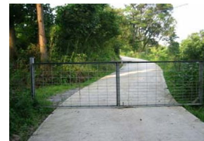
集落入口道路への防護柵設置 (開閉式)
