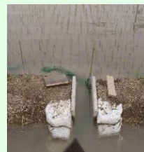
水路と水田との接続部
