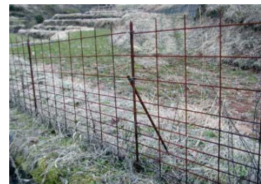
防護柵の設置状況
