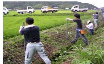
侵入防止柵の設置
