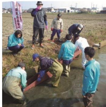
④集落総出で魚道を設置
