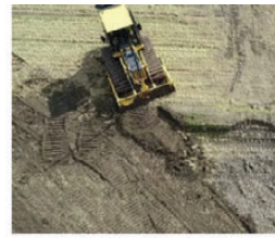
農業ブルドーザによる畔倒し
