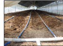
灌水チューブ設置
