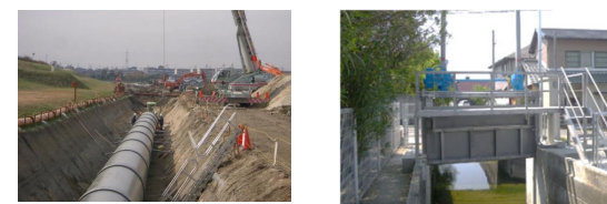
水路のパイプライン化
