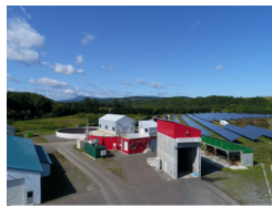
興部北興 バイオガスプラント
