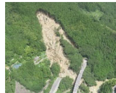
豪雨による大規模な山地災害の発生
