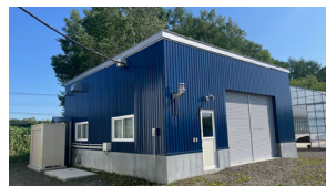
メタン酸化技術 開発研究棟
