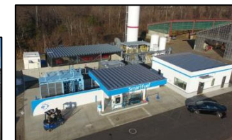
水素ステーション
